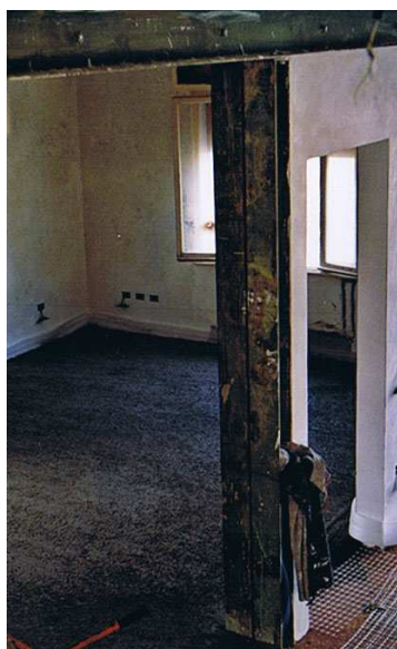
Pavimento ventilato (sughero, rete tenax, massetto)
