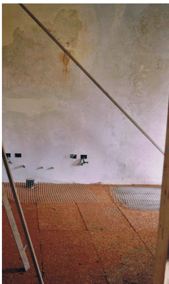
Pavimento ventilato (sughero, rete tenax, massetto)
